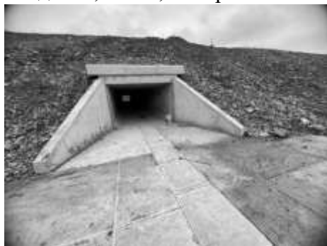
Рис. 1. Прямоугольная труба под автомобильной дорогой
