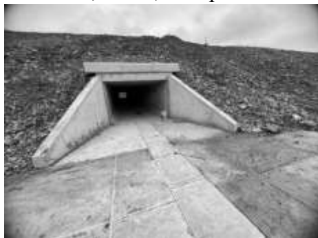
Рис. 1. Прямоугольная труба под автомобильной дорогой
